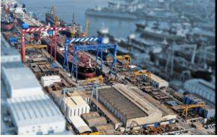
TUZLA TERSANE BAYKAR İNŞAAT 144 DAİRE
