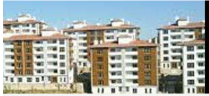
TOPLU KONUT PROJESİ TARKAN İNŞAAT & EMLAK KONUT 686 DAİRE
